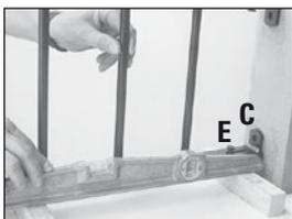
Inserire l'inferriata nel vano muro e regolare le staffe C in larghezza. Per la regolazione agire sulle viti E senza però strappare la testa esagonale. Tenere sollevata l'inferriata dal davanzale (circa 4 cm) aiutandosi con spessori in legno o plastica. Usare la livella per l'allineamento orizzontale e verticale dell'inferriata.
