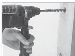
Togliere l'inferriata ed eseguire i fori nel muro con il trapano a percussione. Se il muro è di mattoni pieni usare una punta Ø 14 mm; se invece è di mattoni vuoti usare una punta Ø 16 mm.
